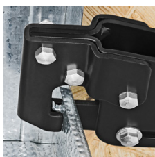
Установка инструмента на оба соединяемых профиля
